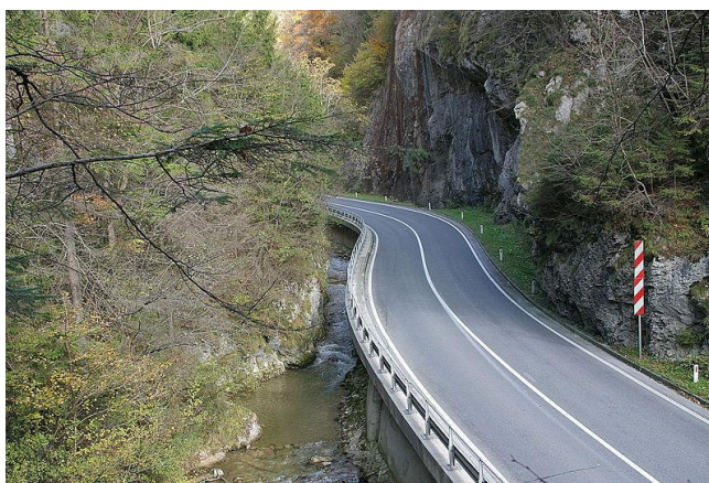
Slika 5: Soteska Huda luknja, kjer poteka glavna prometna povezava na Koroško (Vir: Wikipedia Paka, 2016)
